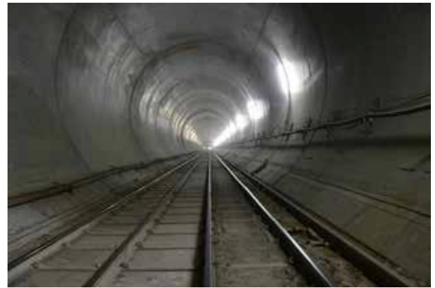
Segmentos prefabricados de Hormigón durable, que forman el revestimiento final de las dos galerías principales del túnel
