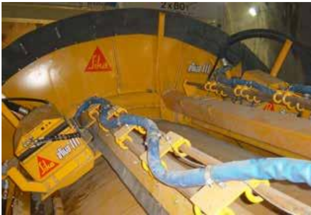
Estabilización del túnel con hormigón proyectado vía húmeda, aplicado desde la sección de la TBM.
