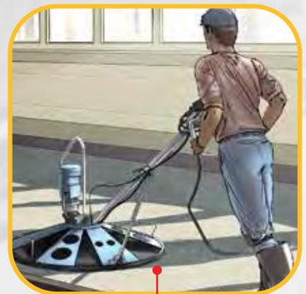
Terminación de piso resistente al desgaste.
