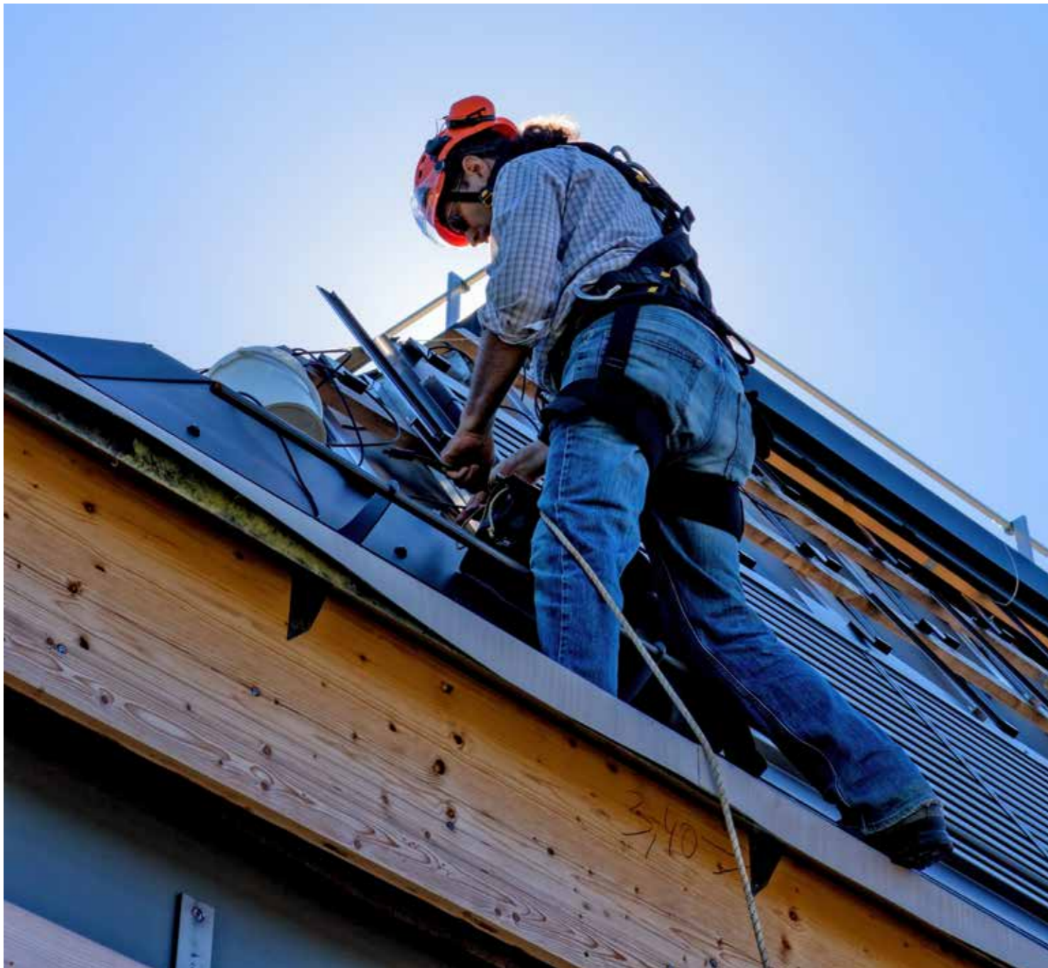
El techo metálico inclinado está impermeabilizado por el sistema de membrana Sarnafil® TG66-15, que incluye 2 capas de aislamiento térmico de lana mineral.
