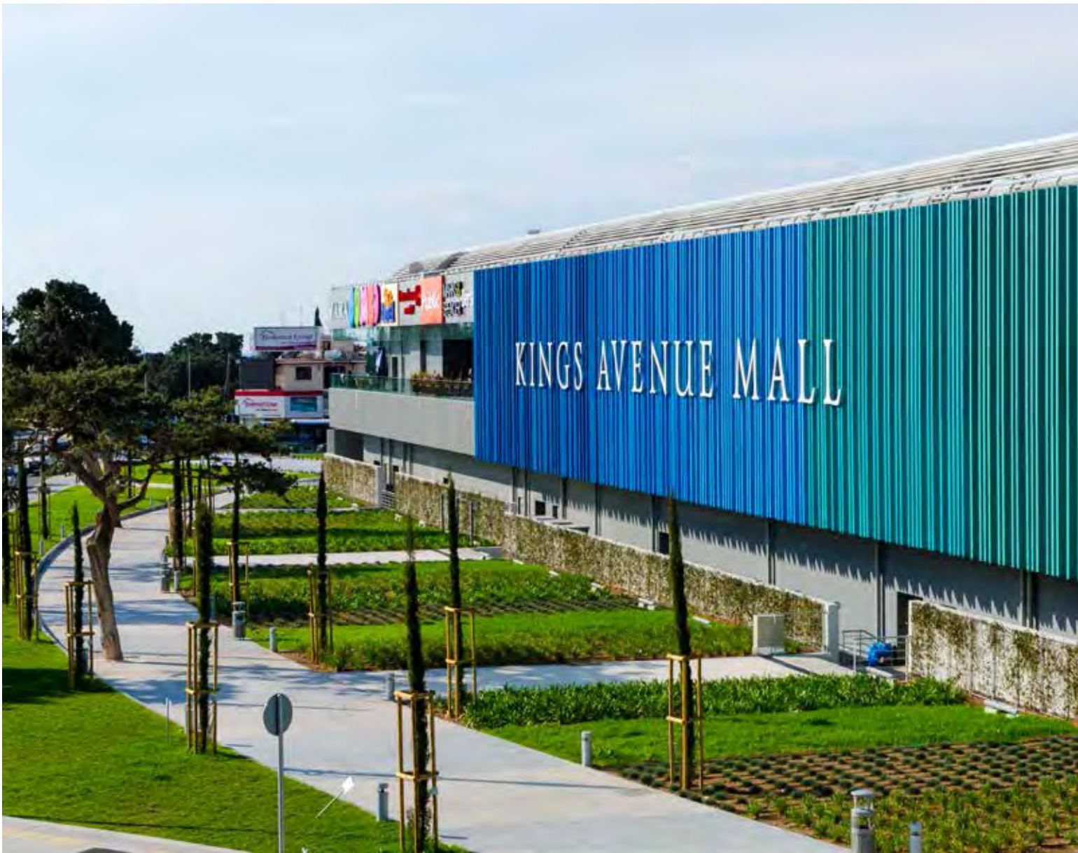
La fachada exterior impresionante tiene nido de abeja de aluminio ligero más llamativo, desarrollado y fabricado por Metallock en Grecia.
