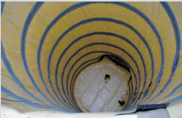
NBS Fránfort– Colonia/Alemania Pozo para salida de emergencia con Sikaplan® WT 2200 – 31 HL2 y tranca para agua MP AFI 600 / 35
