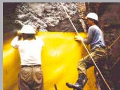
Ignorar los requerimientos del sustrato y omitir los materiales protectores de apoyo
