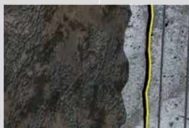
Hormigón lanzado con SikaCem®-Gunite®
