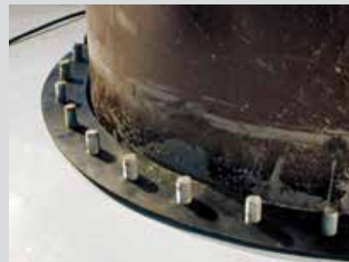
Construcción de flanche suelto en caso de presión del agua.
