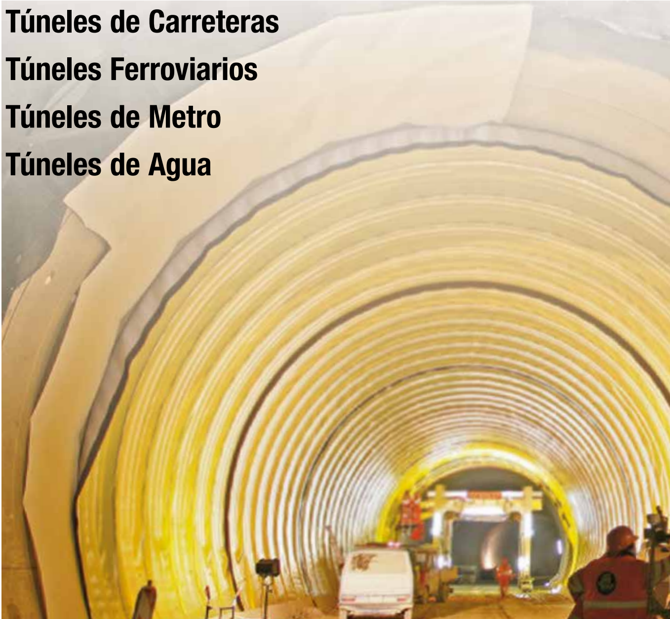
Islisberg / Suiza: Construcción con TBM con Sikaplan® WP 2110-20HL y fijado mediante fundido en caliente
