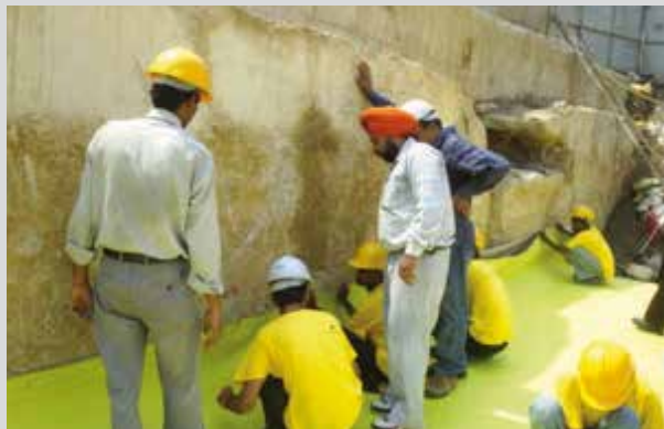
DMRC/India Construcción a cielo abierto con Sikaplan® WP1100 20HL.
