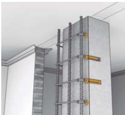
Anclajes de barras de construcción en recocado de pilar
