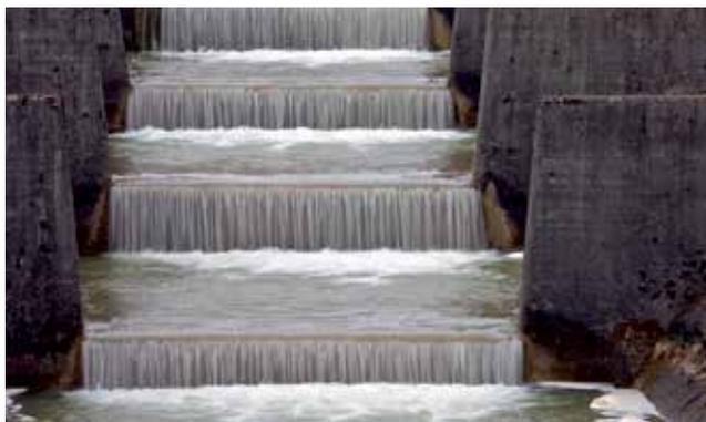
Particularmente en rápidos, las superficies de hormigón están sujetas a masivas fuerzas adicionales por arrastre de partículas, bordes afilados y abrasión, así como posibles tensiones por temperatura debido a la exposición al congelamiento.
