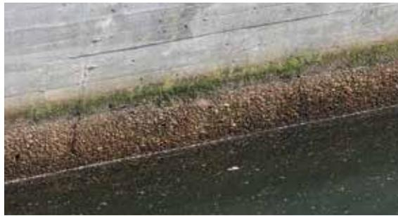
**Fuerte lixiviación y daño a la estructura de hormigón se observa particularmente en zonas de salpicaduras de agua de estanques de tratamientos biológicos.**
