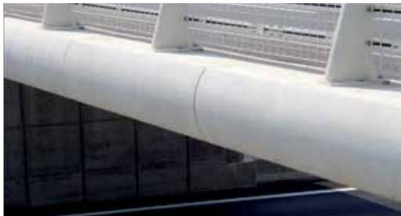
**Los componentes de la estructura altamente tensionados, tales como columnas y vigas están hechos de hormigón de alta resistencia. La alta resistencia a las influencias externas hace también del hormigón de alta resistencia mecánica un recubrimiento de protección ideal para elementos de construcción expuestos.**
