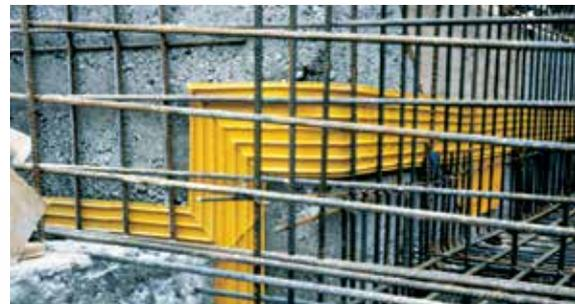
**Sika Waterbars son cintas impermeables de PVC preformadas para la impermeabilización de las juntas con movimiento y de construcción, las que pueden estar sujetas a altas y bajas presiones de agua.**
