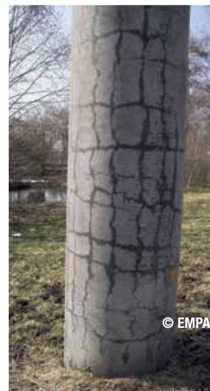
**La apariencia del daño por RAS puede evaluarse muy bien en la superficie seca del hormigón de esta columna de puente. El daño puede aparecer dentro de años o sólo después de décadas.**
