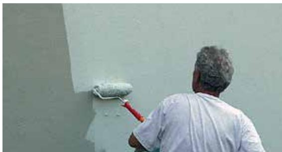
**Un revestimiento epóxico protector se aplica sobre toda la superficie después del reperfilado de la superficie de hormigón y reparación con mortero resistente al sulfato.**
