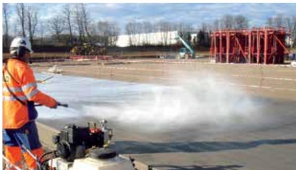
**La inmediata aplicación del compuesto de curado a las superficies de hormigón expuestas es el paso más crucial para la protección de tales superficies.**
