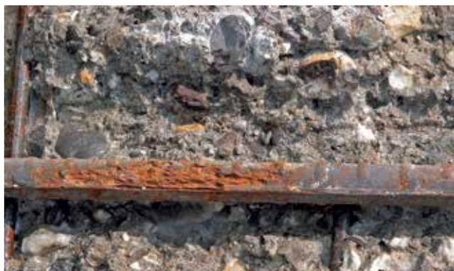
Daño a la estructura del hormigón debido a insuficiente recubrimiento y baja calidad del hormigón.
