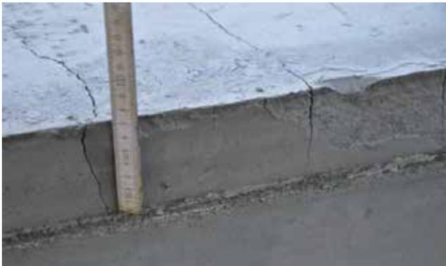
Grietas debido a retracción plástica en un pavimento de hormigón provocadas por una protección insuficiente de la superficie antes del secado prematuro.
