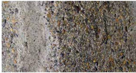
**Debido a la exposición continua, la lechada o mortero de cemento se erosiona en un primer paso y después mayores y mayores cantidades de árido se pulen, se rompen o desprenden de la pasta de cemento endurecida.**
