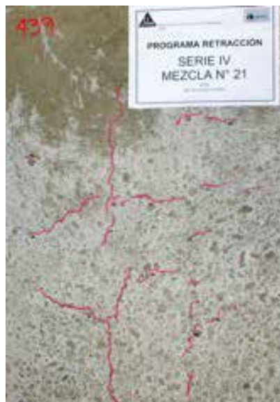
Figura 2. Hormigón 4000 psi a las 24 hrs, expuesto a viento de 2 m/s
