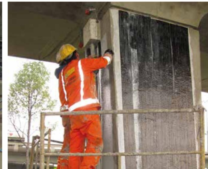
Igualmente las vigas longitudinales se reforzaron con el tejido de fibra de carbono Sika®Wrap® 300C en las zonas de apoyo con las pilas. El Sika®Wrap® 300C se colocó en el sentido vertical y en el sentido horizontal para interceptar los esfuerzos allí generados.
