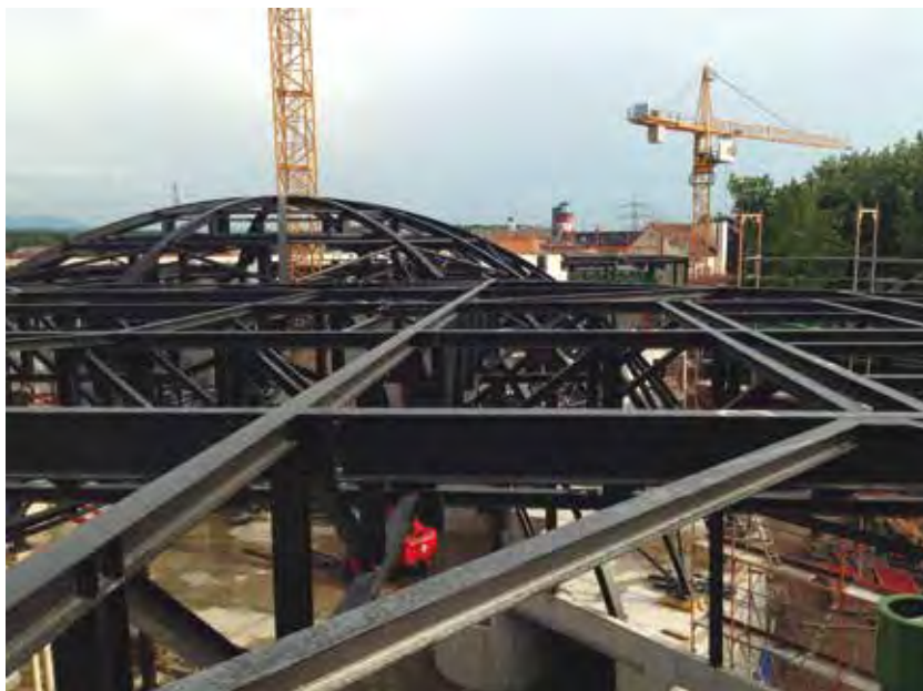
Un armazón de estaño sirve de estructura soporte de carga para el aula y la cúpula.
