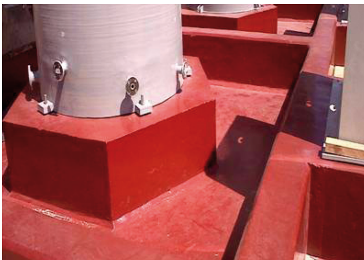
Pretilas de contención ácido sulfúrico. Industria energética. 5ª Región (2013).
