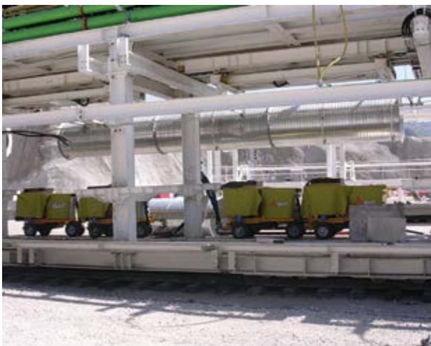
Foto 3.- Acopio de dovelas. Bombas Sika-Aliva en una TBM
