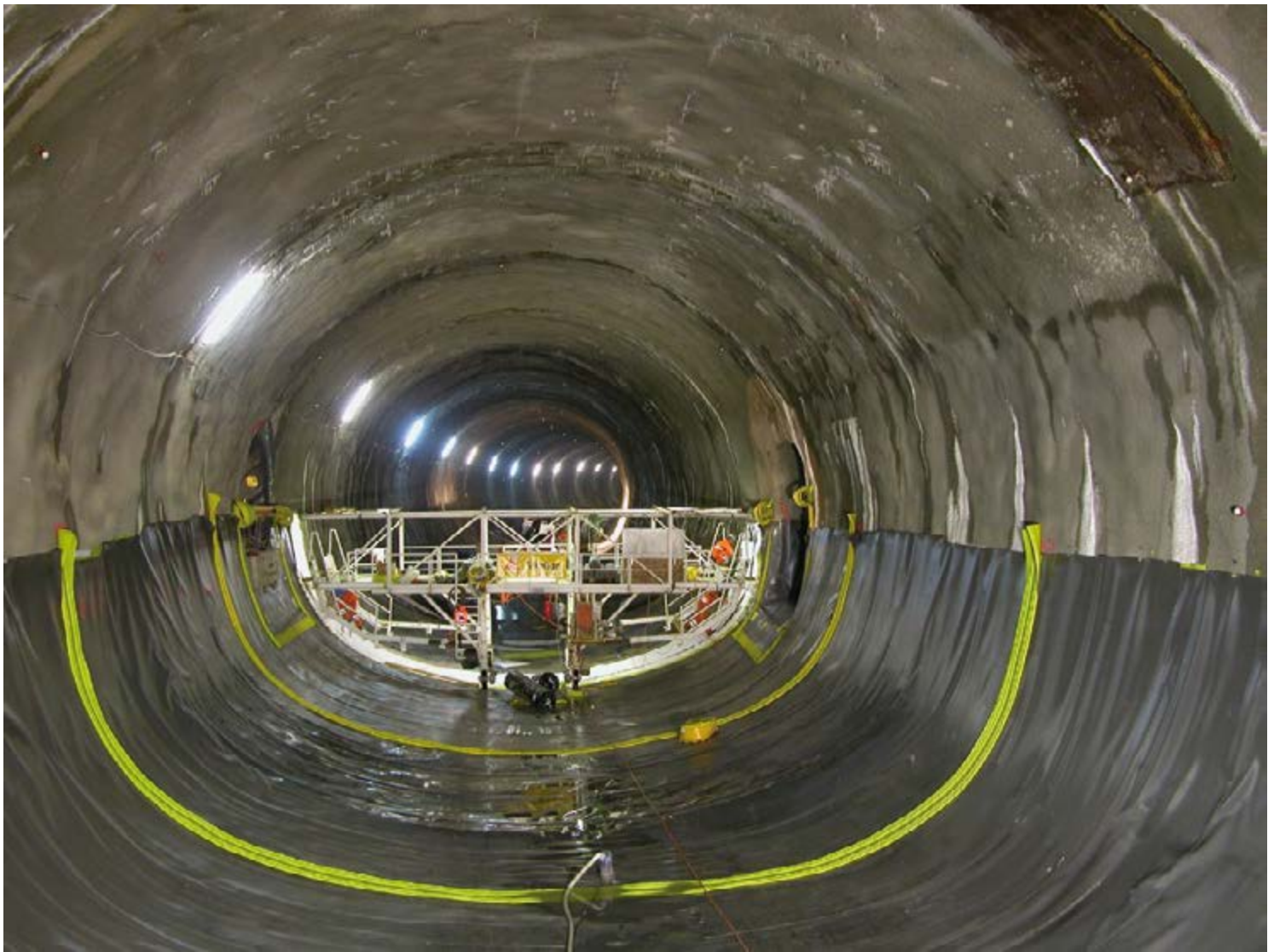
Foto 22.- Membrana de protección en solera y cintas flexibles de PVC
