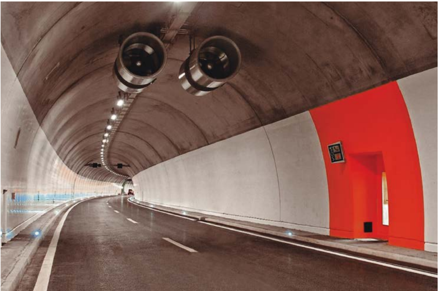
Foto 9.- Hormigón de revestimiento de túnel terminado
