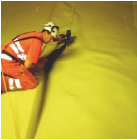
Foto 25.- Equipo de doble soldadura y campana de vacío
