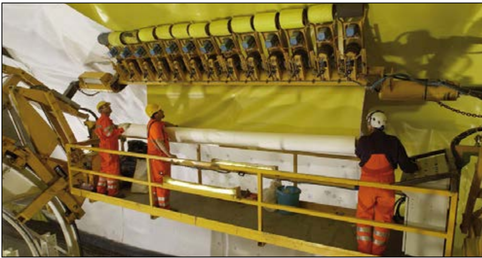
Foto 20.- Colocación de lámina de PVC-P en un túnel
