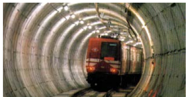
Foto 10.- Revestimiento de tunnel con dovelas prefabricadas
