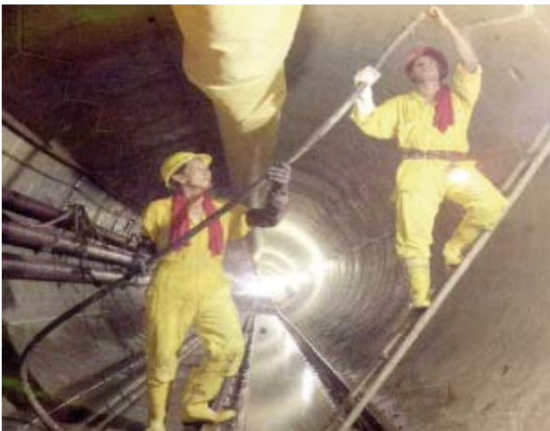
Foto 17.- Labores de inyección en un túnel
