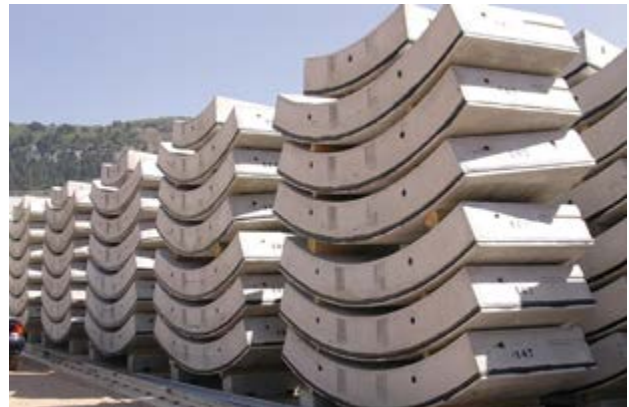
Foto 27.- Fratasado de dovela base. Acopio de dovelas
