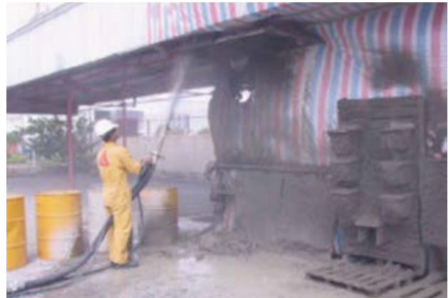
Foto 5.- Ensayos previos de adherencia sobre paneles
