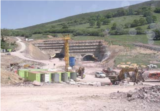
Foto 1.- Emboquille convencional complejo y montaje de TBM.
