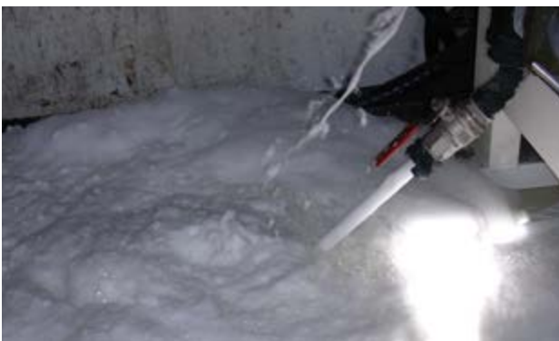
Foto 26.- Detalle de las espumas en una TBM
