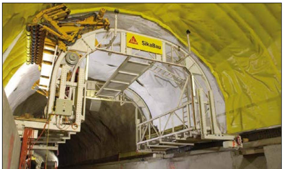
Foto 21.- Carro de colocación de lámina
