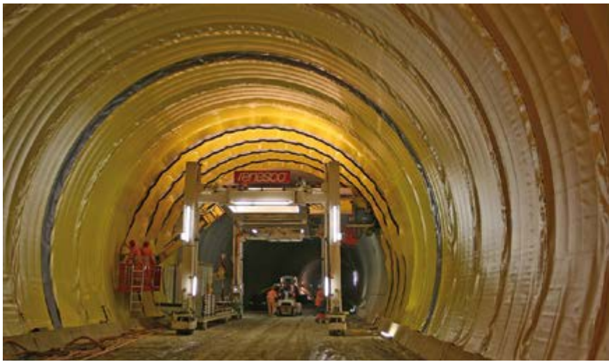
Foto 18.- Lámina de PVC colocada en un túnel y detalle del anclaje de la lámina
