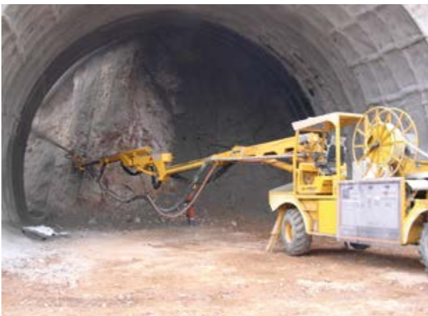
Foto 7.- Robot de gunitado Sika PM 500. Proyección de talud de emboquille
