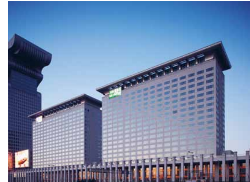
Inferior Edificio CNOOC, Beijing, 2005 Arquitectos Kohn Pedersen Fox Associates PC; Fachada Josef Gartner.
