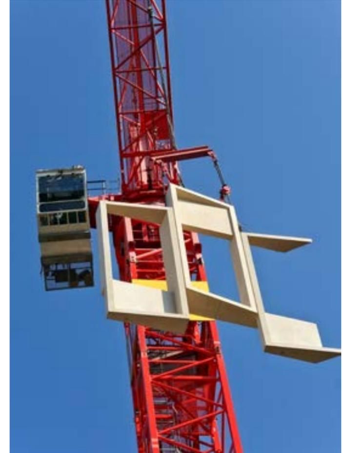
Antes de instalar los elementos prefabricados en la fachada, se retiró el andamio que rodeaba el edificio. Los elementos fueron subidos con una grúa del equipo de montaje y ubicados en posición en el armazón de la fachada, uno por uno, en cada piso.
