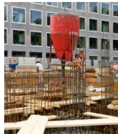
El hormigón impermeabilizado se especificó con retracción reducida para las losas de piso y los muros centrales. Esto puede realizarse reduciendo la relación agua/cemento y usando Sika® Control-60.
