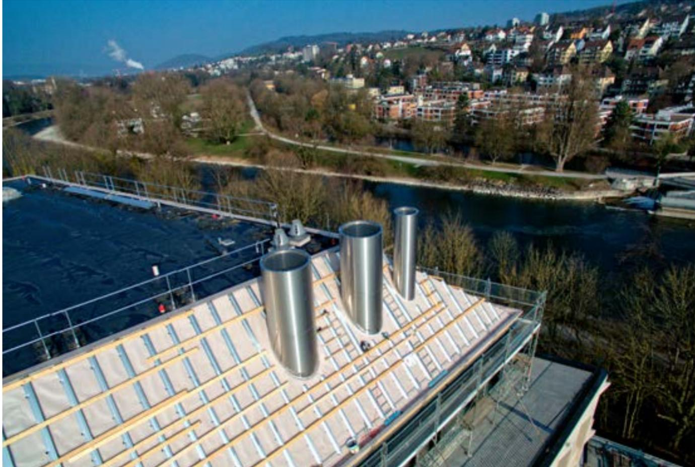
Esta cubierta inclinada está impermeabilizada con el sistema de membrana Sarnafil® TG 66-15 que incluye dos capas de aislamiento térmico de lana mineral. Sobre el sistema de membranas, lazos sobre los que, a su vez, se instalaron los paneles solares.
