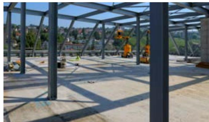
El techo se compone de una estructura de acero sobre una losa de hormigón. SikaCor® PUR Neu en un tono RAL 7046 de gris ha sido usado para dar una protección anti corrosión durable y a largo plazo.
