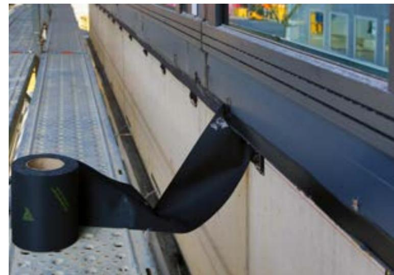
El sistema Sika® Membran se usó para el sellado de las ventanas que conforman la fachada, para asegurar juntas herméticas que impidan el paso de aire y agua y para prevenir la condensación intersticial o interna. Este sistema previene la pérdida de calor y frío para regular el ambiente con eficiencia energética.
