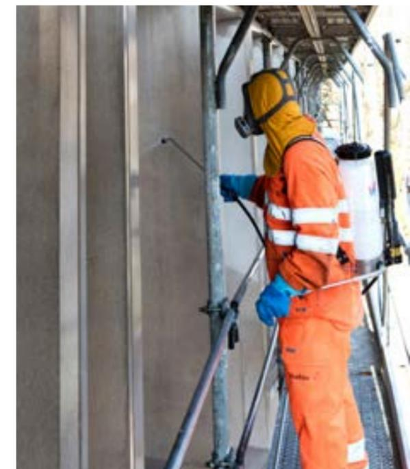
Una vez instalados los elementos de hormigón de las fachadas, se recurrió a una protección adicional con impregnación hidrófoba. Se aplicó Sikagard®-703 W en spray de baja presión para penetrar las superficies, impermeabilizar y además proteger de la suciedad, brotes verdes y otros microorganismos.
