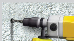
Perforar de acuerdo a diámetro y profundidad requeridos.
