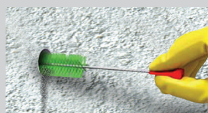
Limpiar la perforación con aire y/o cepillo.
