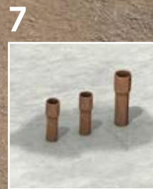
Filtraciones en Penetraciones (ej. tuberías).
