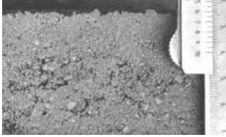
Borde rústico sin compuesto estabilizante
